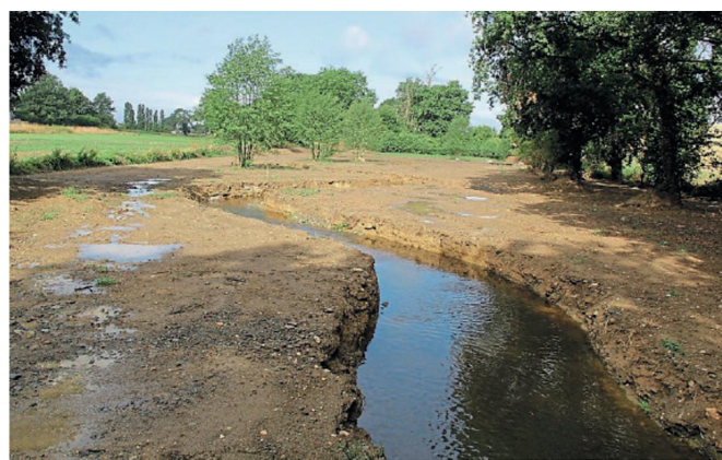
Les travaux de reméandrage ont permis à l'Isle de retrouver son lit.
